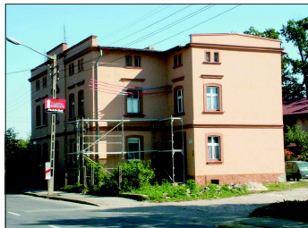
Nazwa inwestycji: Remont i malowanie elewacji oraz wymiana rynien i rur spustowych w budynku mieszkalnym zlokalizowanym przy ul. Wrocławskiej 17B w Jaworze Całkowity koszt: 14.428,79 zł
