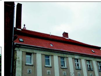
Nazwa inwestycji: Termomodernizacja obiektu Szkoły Podstawowej nr 5 przy ul. Armii Krajowej 9 Całkowity koszt: 1.909.683,21 zł
