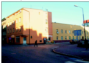
Nazwa inwestycji: Remont kompleksowy pokrycia dachowego ceramicznego z dachówki karpiówki 18 x 38 w budynku przy ul. Kościelnej 13 w Jaworze. Całkowity koszt: 44.286,54 zł
