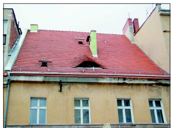
Nazwa inwestycji: Wymiana pokrycia dachu Teatru Miejskiego w Jaworze Całkowity koszt: 380.743,65 zł
