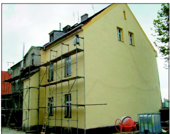
Nazwa inwestycji: Remont kompleksowy pokrycia dachowego ceramicznego z dachówki karpiówki 18 x 38 w budynku przy ul. Kościelnej 10 w Jaworze. Całkowity koszt: 67.376,77 zł
