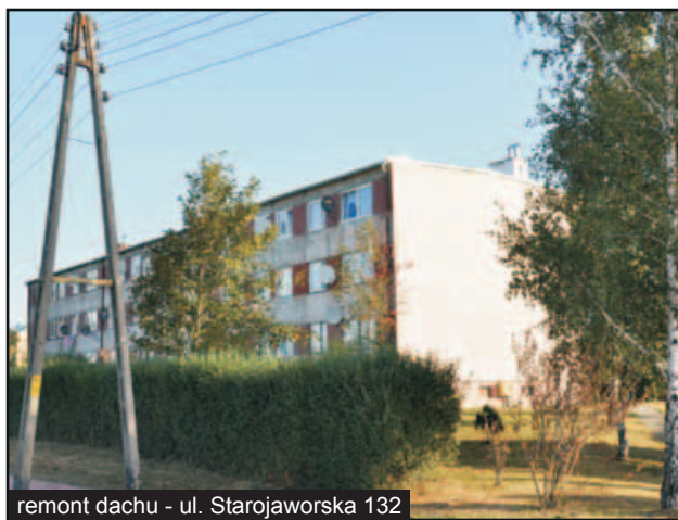
remont dachu - ul. Starojaworska 132
