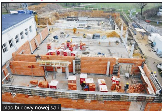
plac budowy nowej sali
