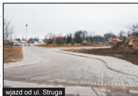
wjazd od ul. Struga
