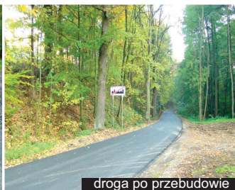
droga po przebudowie
