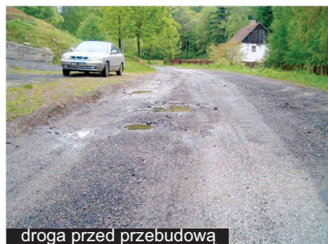
droga przed przebudową
