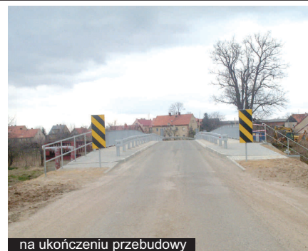
na ukończeniu przebudowy
