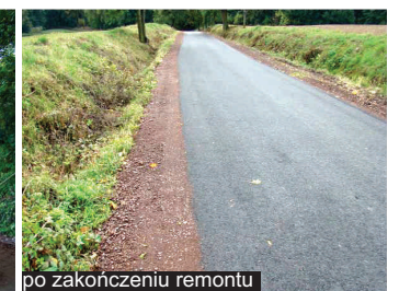
po zakończeniu remontu
