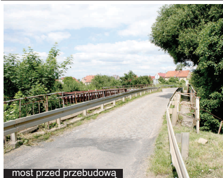
most przed przebudową
