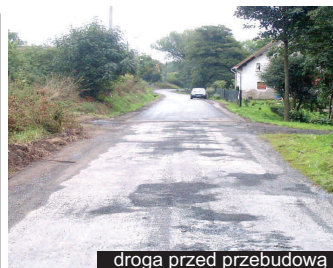
droga przed przebudową
