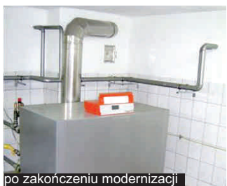
po zakończeniu modernizacji
