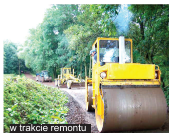
w trakcie remontu
