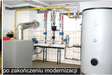
po zakończeniu modernizacji
