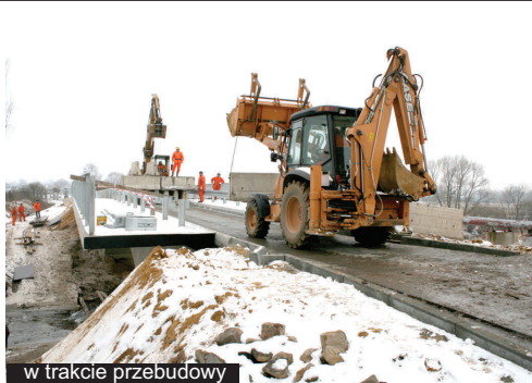
w trakcie przebudowy
