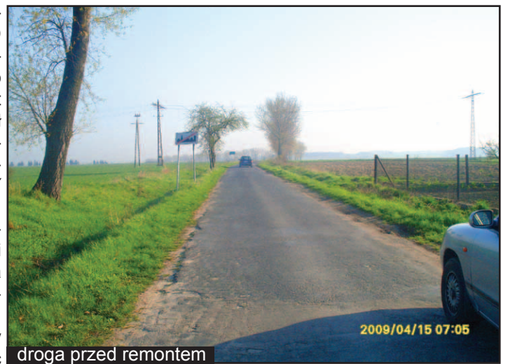
droga przed remontem
