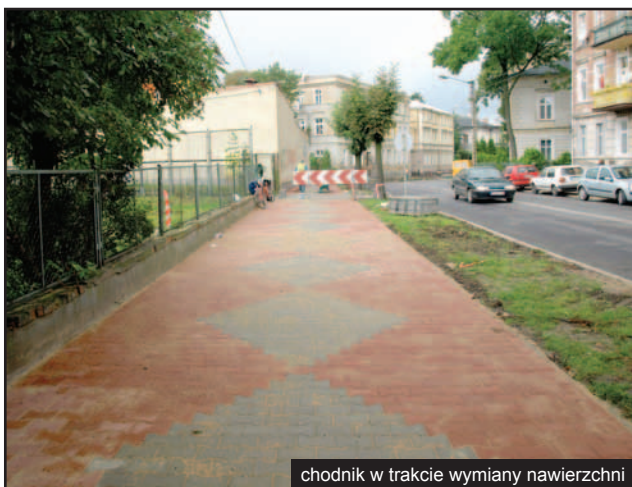
chodnik w trakcie wymiany nawierzchni
