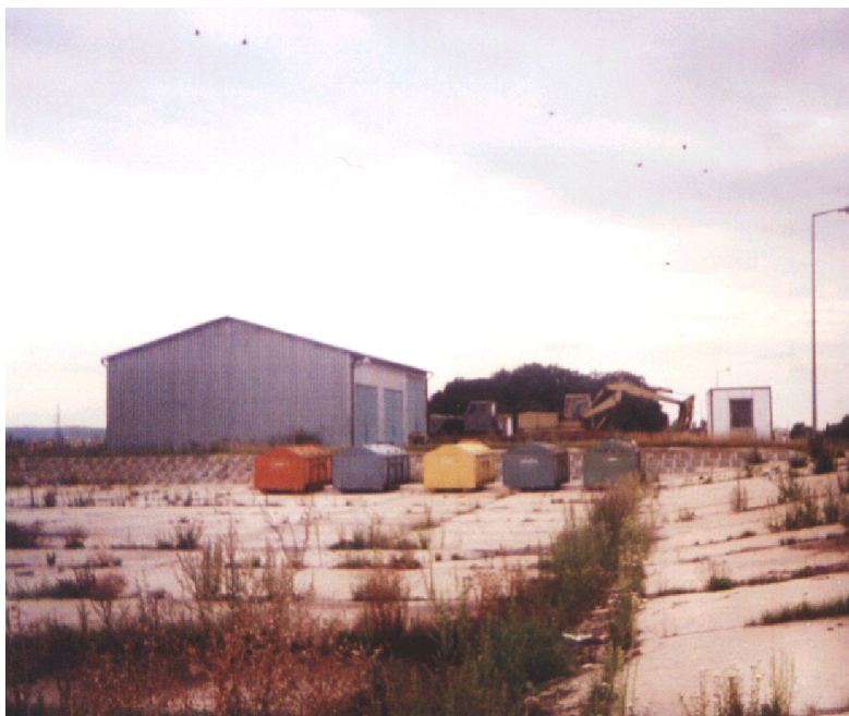
Fot. III.2. Plac z kontenerami na selektywnie zebrane odpady - składowisko Jawor
