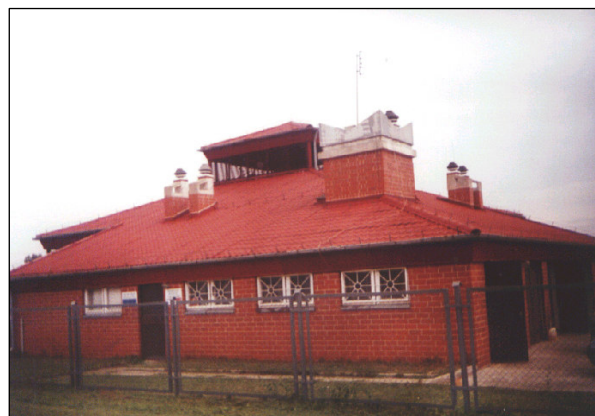
Fot. II.5. Oczyszczalnia ścieków w Mierczycach
